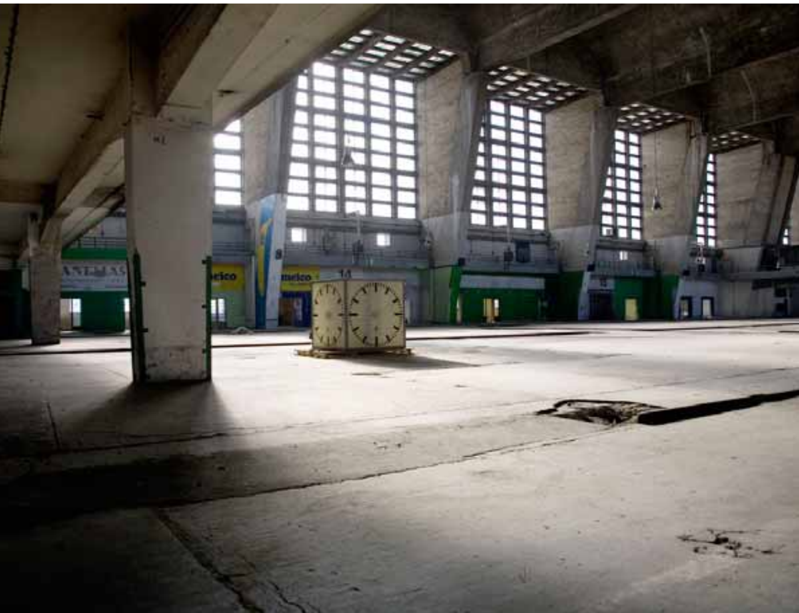
Kuva Grossmarkthallen sisätiloista (helmikuu 2008). Martin Elsaesserin suunnittelema rakennus on suojeltu. Valmistuessaan vuonna 1928 se oli suurin itsekantavaa teräsbetonirakennetta käyttäen rakennettu halli maailmassa.
